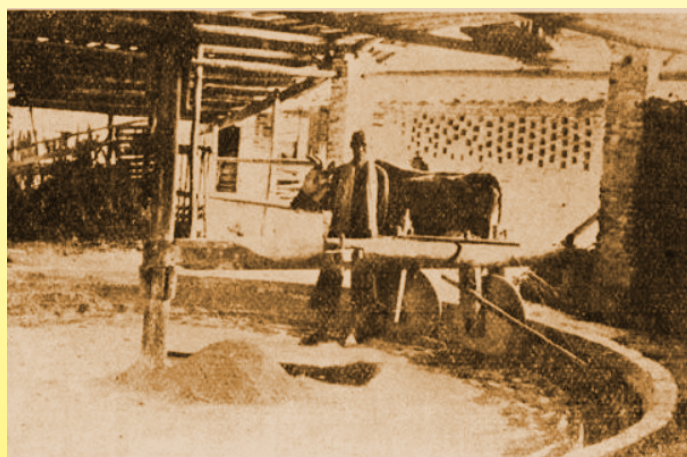
用一头牛拖动研磨机来研磨高岭土 (1939年, Vietnam, 印度支那半岛经济期刊)
